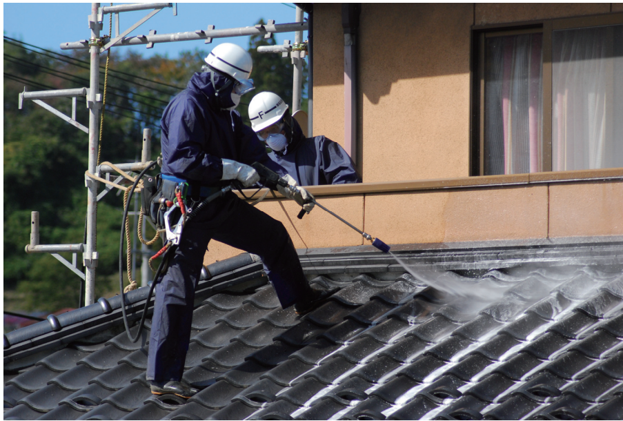
図-2-5：屋根の瓦除染の例（高圧洗浄）
