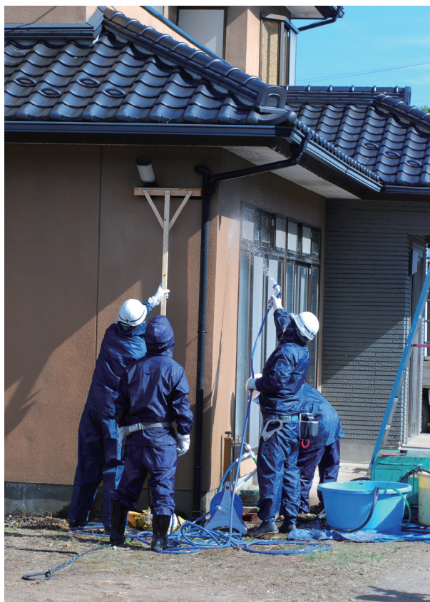
図-2-10：家屋の外壁の除染の例（水洗、こすり取り）
