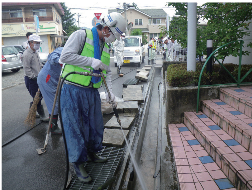
図-2-9：側溝の高圧水除染の例
