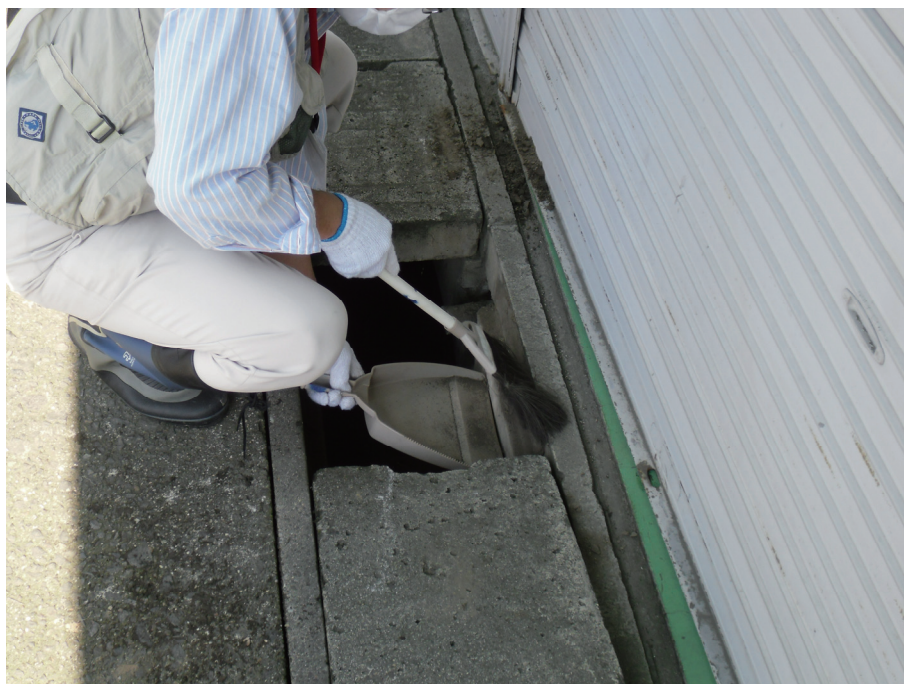
図-2-15：側溝の除染の例（土、ほこりのはき取り）
