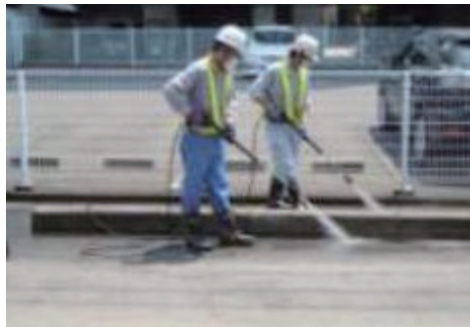
図-2-19 舗装道路の除染の例（高圧洗浄）
