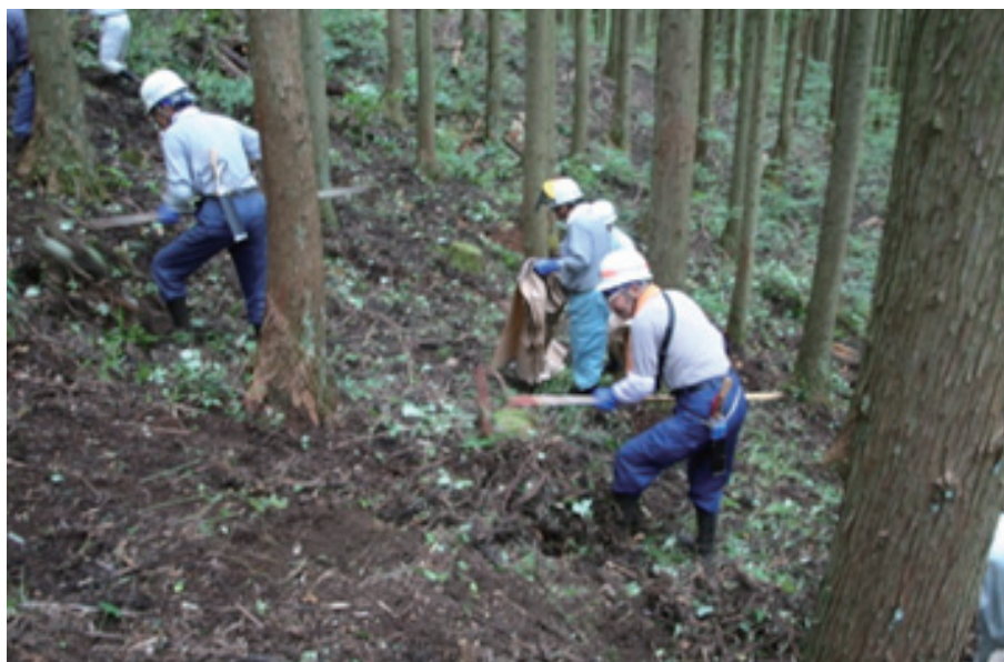
図-2-32：森林の除染（落葉の除去）の例
