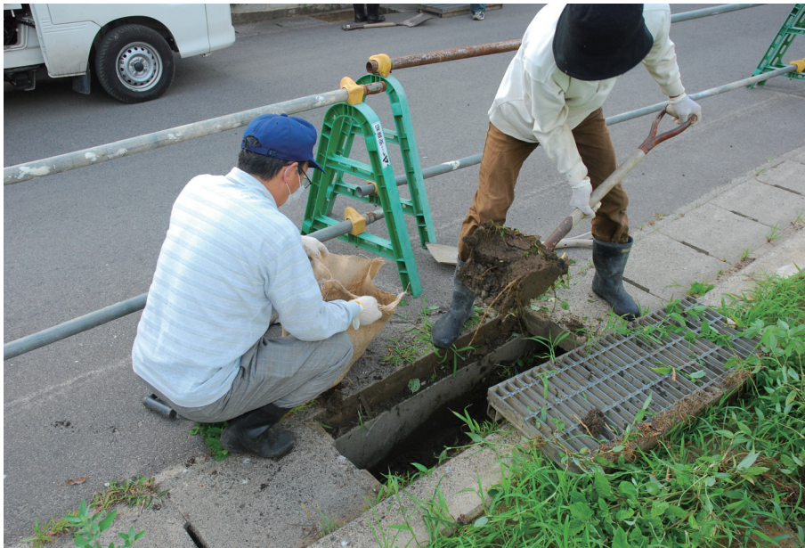
図-2-17：側溝の除染の例（汚泥の除去）
