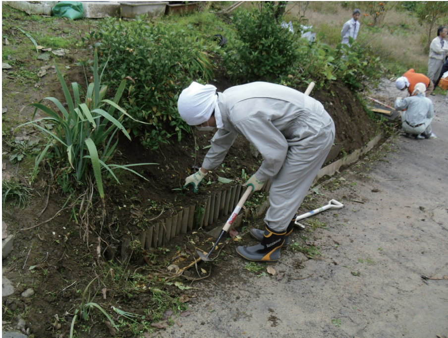
図-2-12：庭等の除染の例（下草等の除去）
