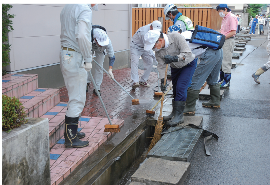
図-2-16：道路脇や側溝の除染の例 （汚泥の除去、タイル目地や側溝隙間のブラシ掛け）
