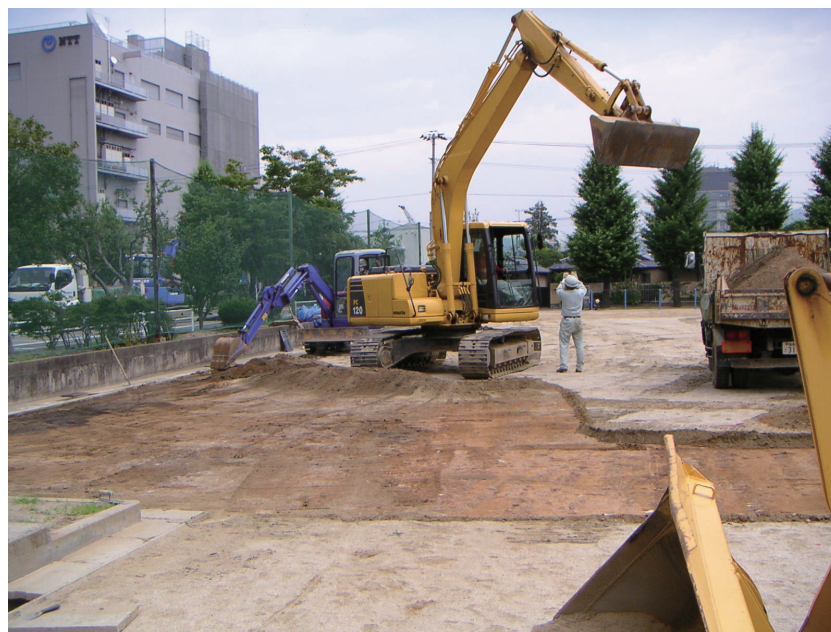
図-2-25：校庭の除染の例（表土の削り取り）
