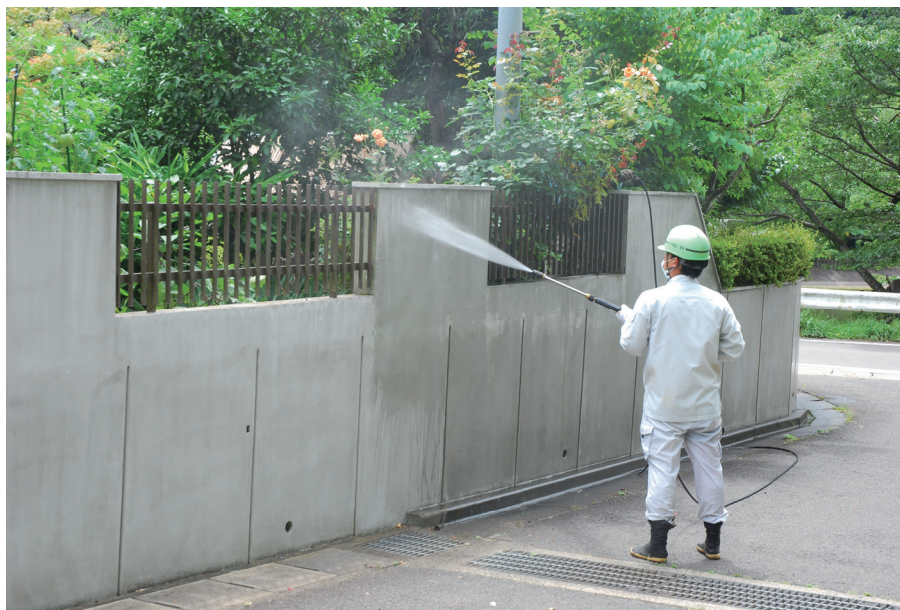
図-2-11：外塀の除染の例（高圧洗浄）
