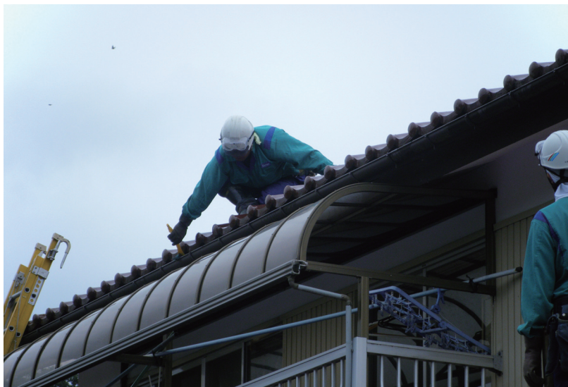
図-2-9：側溝の高圧水除染の例
