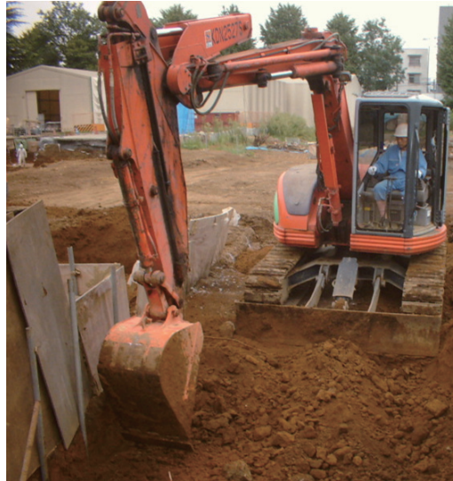
図-2-21 重機による未舗装道路の表土削り取りの例
