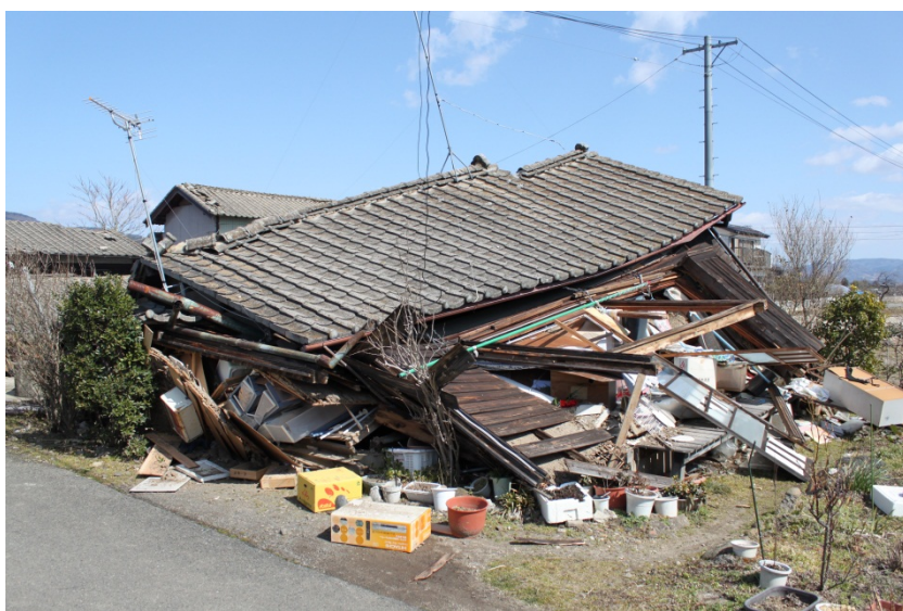
倒壊した町営住宅
