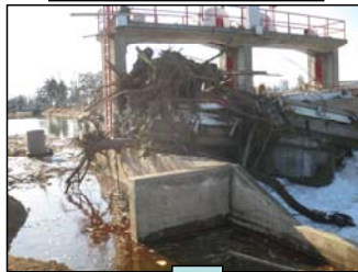
応急復旧状況
