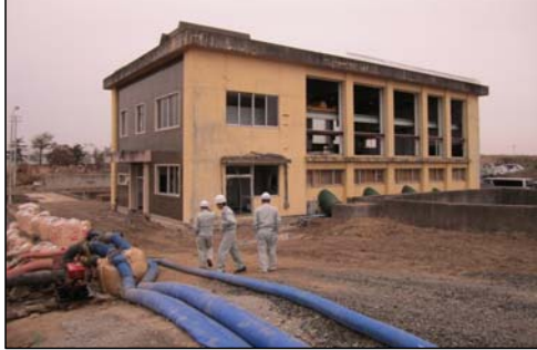
相の釜排水機場
