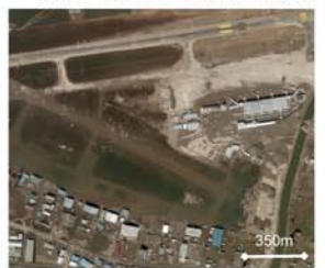
被災後（平成23年3月13日撮影）
