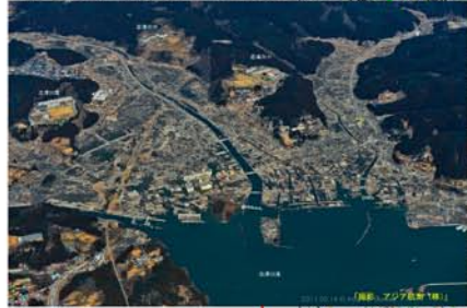
南三陸町 志津川周辺の被災状況
