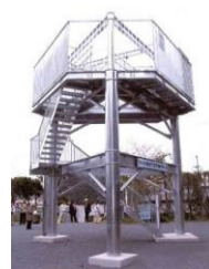
避難タワーの設置
