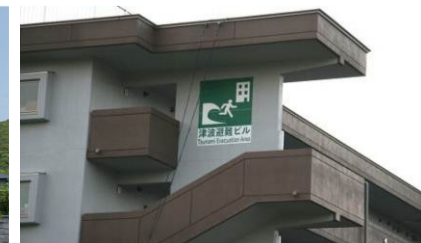
公営住宅等の屋上等の活用
