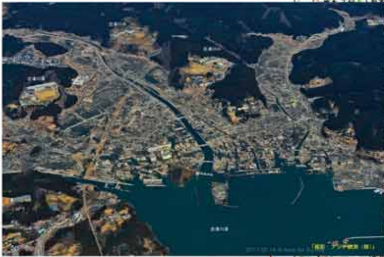
南三陸町 志津川周辺の被災状況
