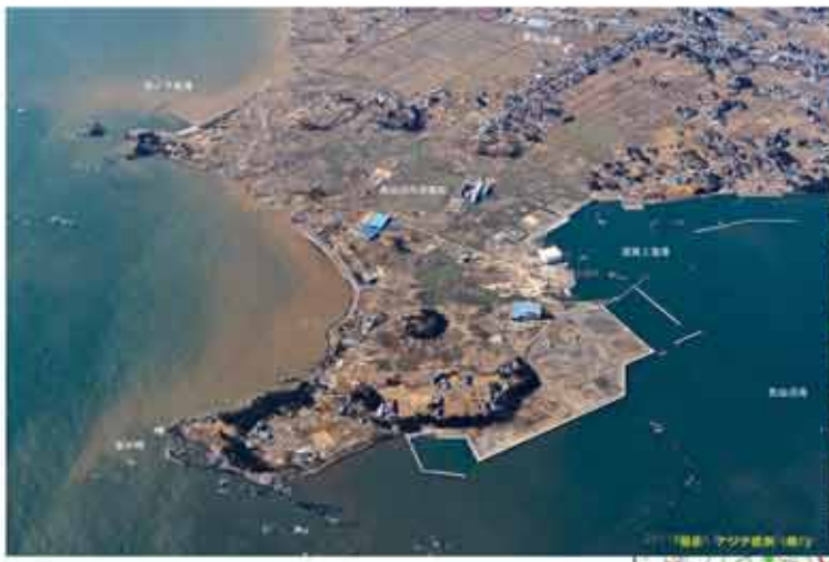
気仙沼市 岩井崎の被災状況
