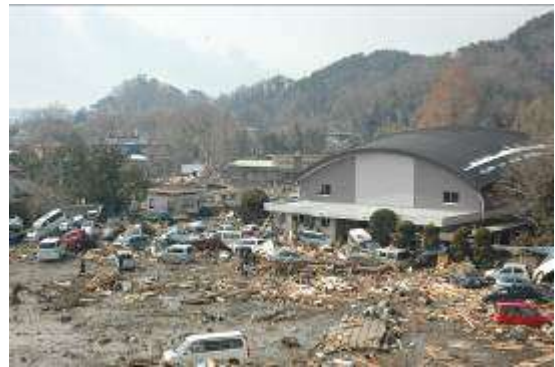
野蒜小学校(体育館)
