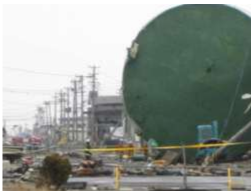
▼石巻漁港臨港道路に流出したタンク
