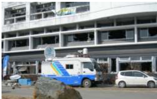
▼ 被災した雄勝総合支所
