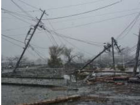
▼ 電柱の倒壊
