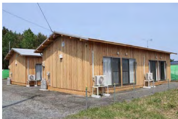
八木地区に建てられた応急仮設住宅
