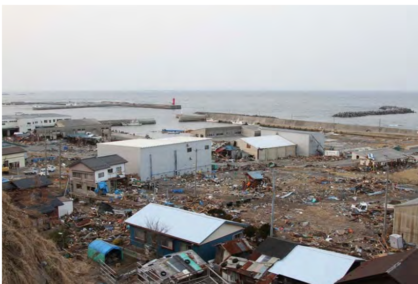
津波被害を受けた八木地区水産加工場
