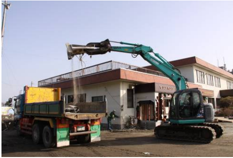
▲三沢市漁業協同組合周辺の瓦礫撤去作業
