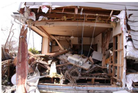
▲津波により損壊した家屋
