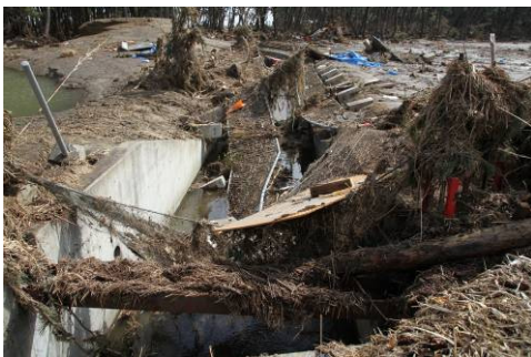
▲損壊した農業用排水路
