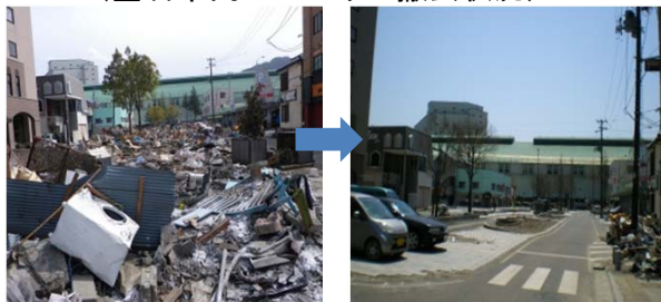
(釜石市内のガレキの撤去状況)
